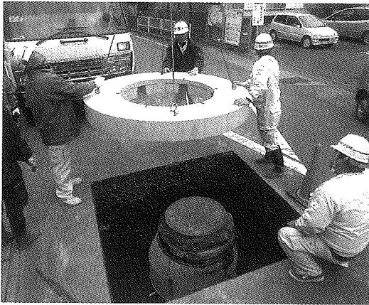
写真-2 マンホールの浮上を抑制する大きな輪(リング)が工法名の由来
